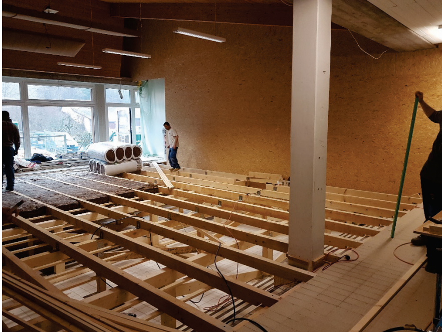
Einbau Holzkonstruktion für den neuen Boden im ehemaligen Schwimmbecken
