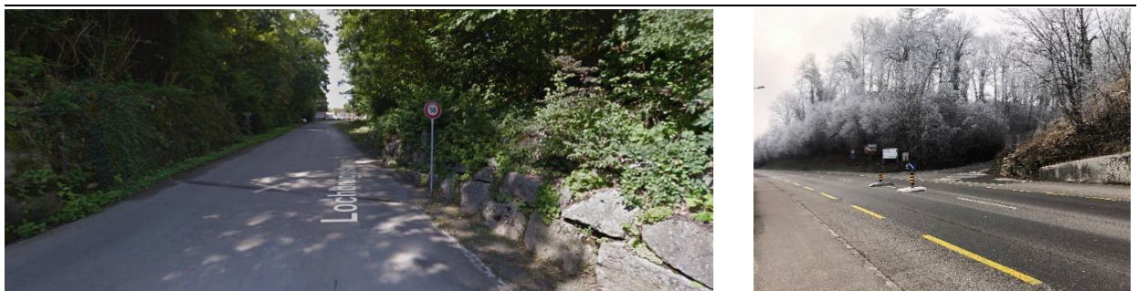
Abb. 19: Die Lochbruggstrasse an leichter Hanglage (Quelle: Google Maps, 2022) und die Kantonsstrasse (Quelle: Jermann AG, 2022)
