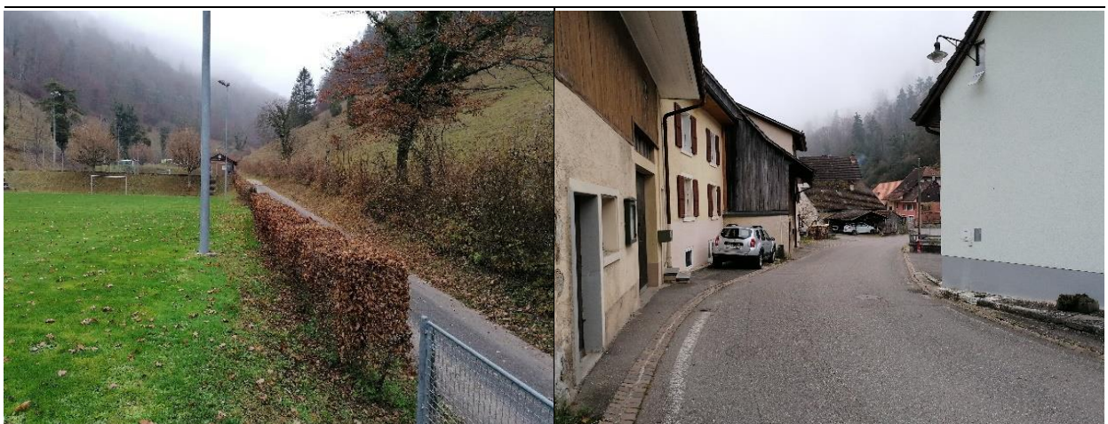
Abb. 14: Der Chälengrabenbach im Zonenplan Siedlung (Bild links) resp. der Dittingerbach (Bild rechts) im Teilzonenplan Dorfkern verlaufen eingedolt unterhalb der Strasse (Quelle: Jermann AG, 2021).
